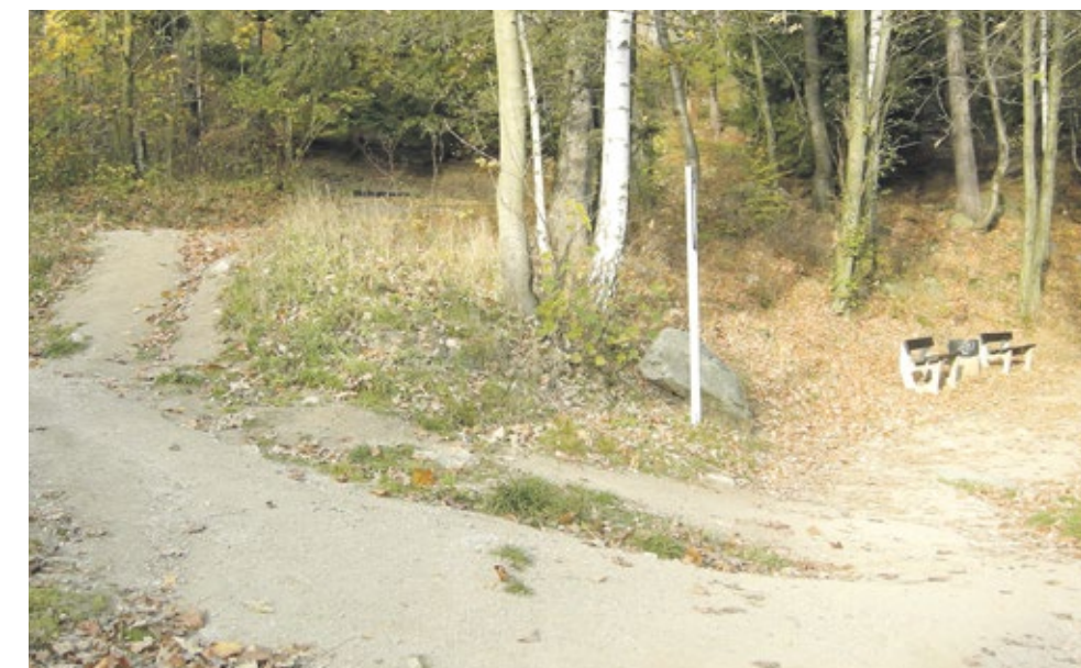
MODERNIZACJA ŚCIEŻKI SZUTROWEJ-WODOSPAD W KARPACZU. DOŚWIETLENIE POSTACI „DUCHA GÓR” LAMPĄ KOLOROWĄ TYPU LED. MONTAZ TABLICY INFORMACYJNEJ OPISUJĄCEJ PRZEMIANĘ DUCHA GÓR W BLASZANE POSTACIE ZWIERZĄT WYSTĘPUJĄCYCH W PARKU.
